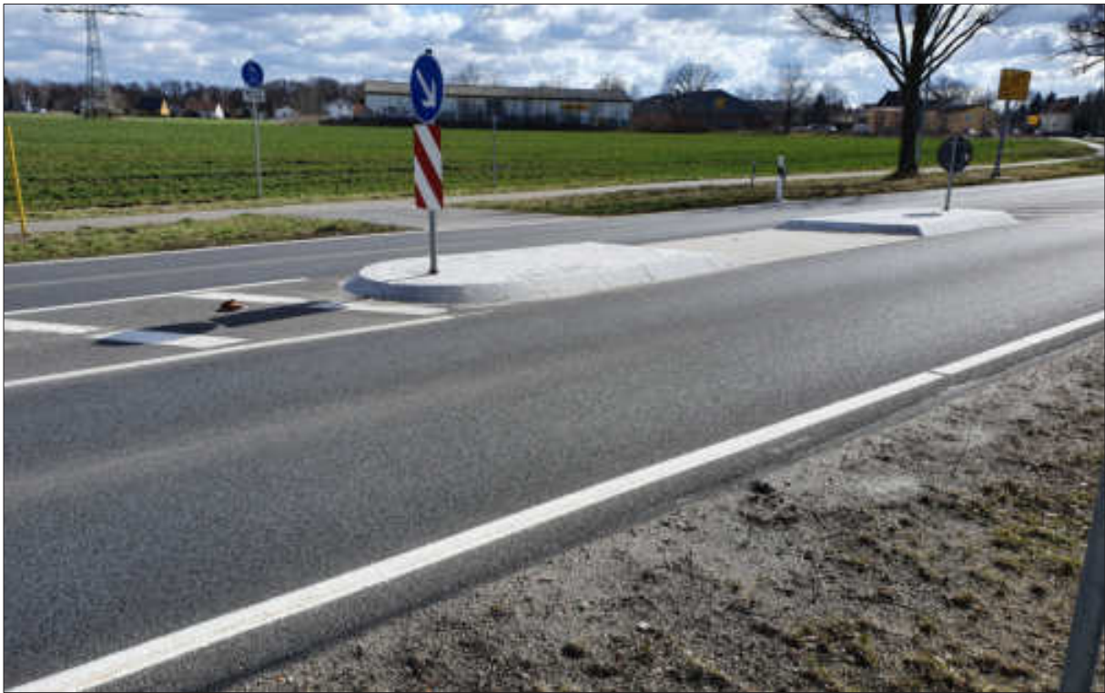
Abbildung 5 Querungshilfe nördlich des Knotenpunkts Berliner Chaussee / L851 sowie gemeinsamer Geh- und Radweg im Zweirichtungsverkehr östlich der Berliner Chaussee
